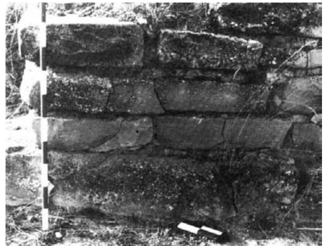
Fig. 5. Detalle del paramento.
