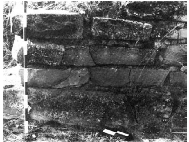
Fig. 5. Detalle del paramento.
