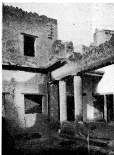
Fig. 3.- Exterior de la misma casa, con la ventana que ilumina el pasillo que da a la estancia
