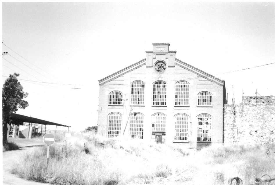
FIGURA 1. FACHADA PRINCIPAL DE LA CENTRAL TÉRMICA DEL «APARTADERO CALATRAVA» EN PUERTOLLANO
